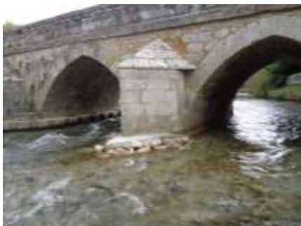
La première phase, engagée en 2018, a permis le renforcement et le confortement des appuis immersés par la protection béton des appuis triangulaires caractéristiques des ponts médiévaux et la mise en place d'enrochements.
